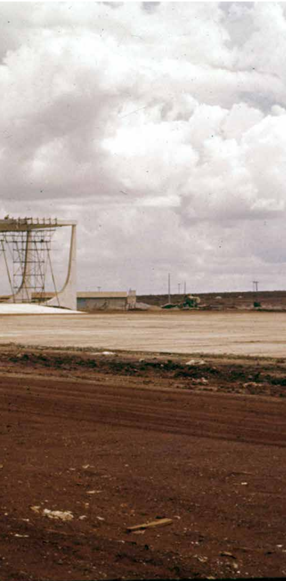
Construção STF - Brasília/DF - 1956/1960
