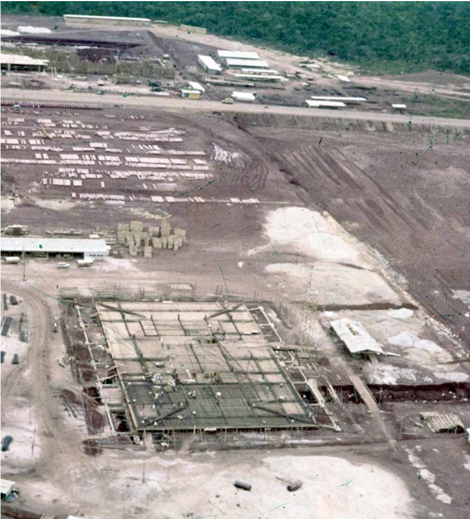
Construção STF - Brasília/DF - 1956/1960
