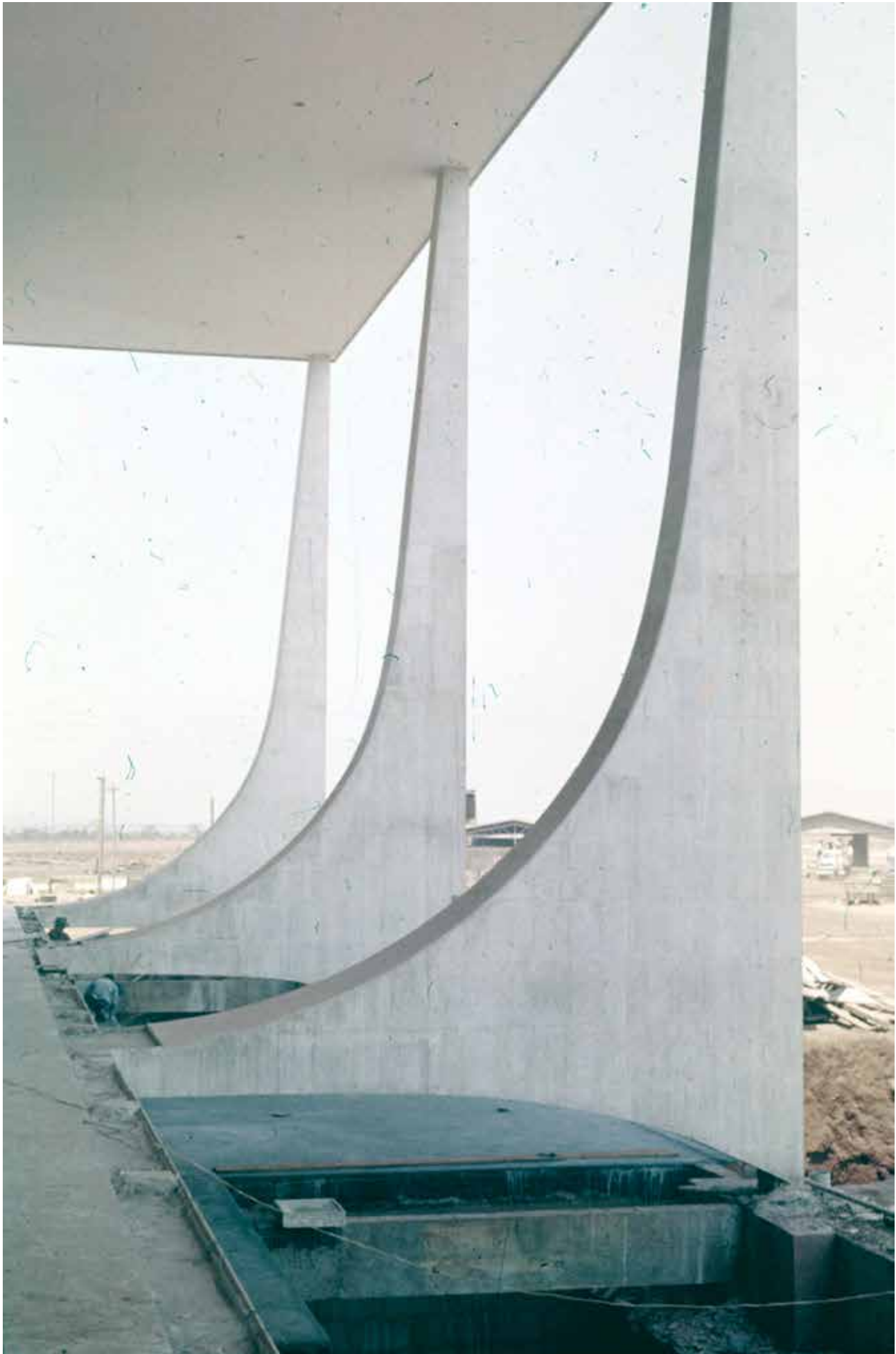
Construção STF - Brasília/DF - 1956/1960
