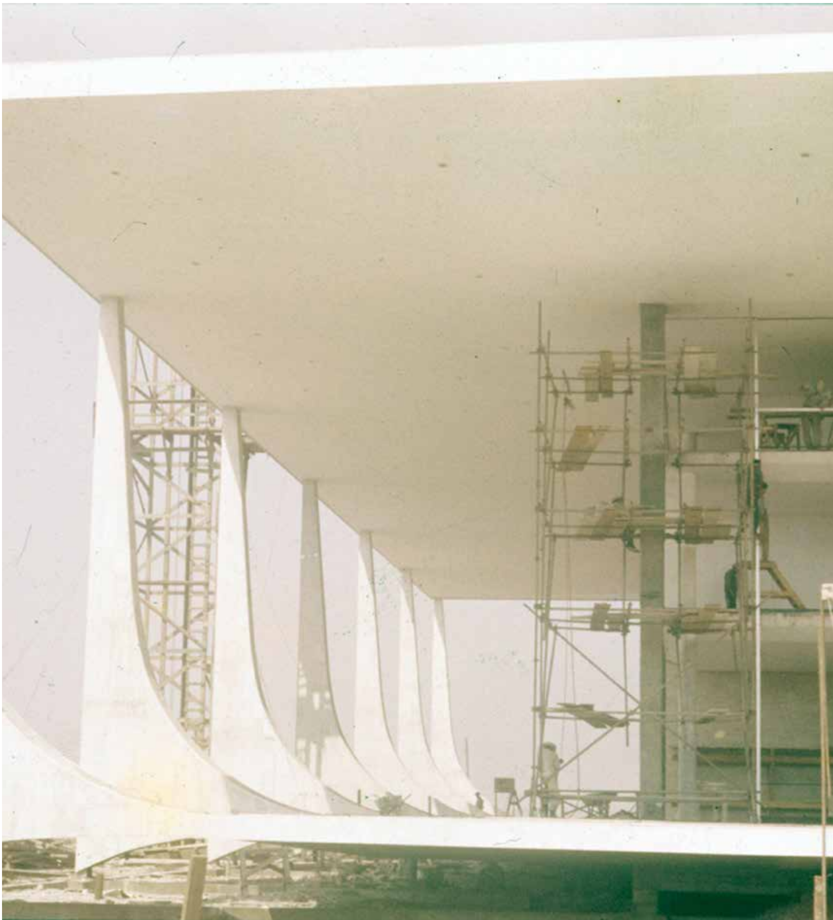
Construção STF - Brasília/DF - 1956/1960
